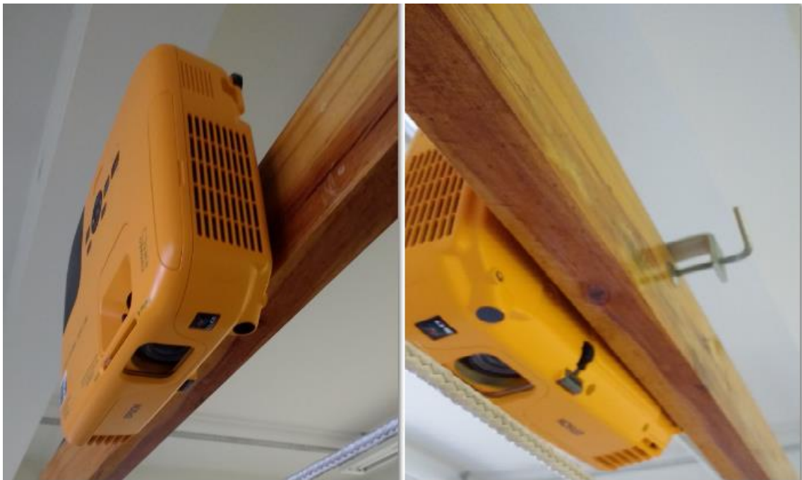
Figura 102 fixação do projetor. Fonte: Autoria Própria
